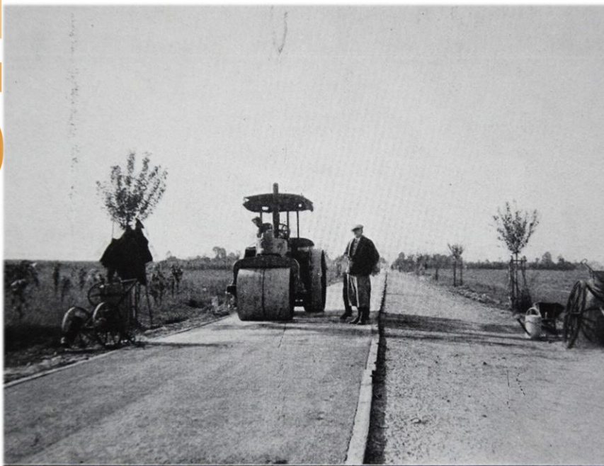
Obr. 64. Válcování těžké vozovky asfalto-dehtové před Buštinou.
