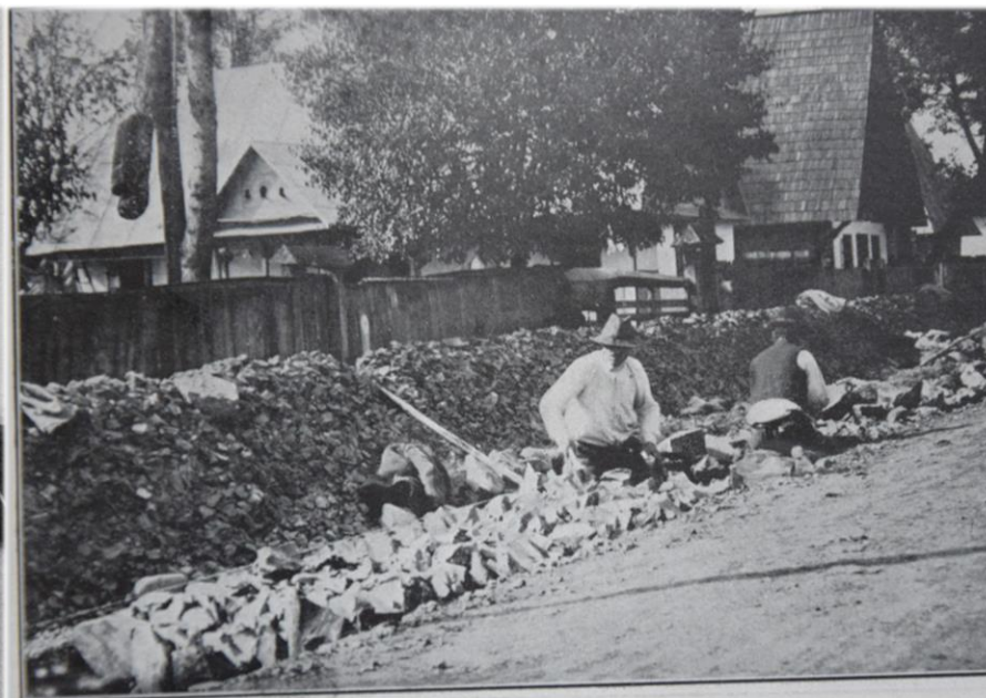
Obr. 38. Přistětování krajů prováděné před válcováním podkladu. Státní silnice Košice-Jablonice v Buštině.
