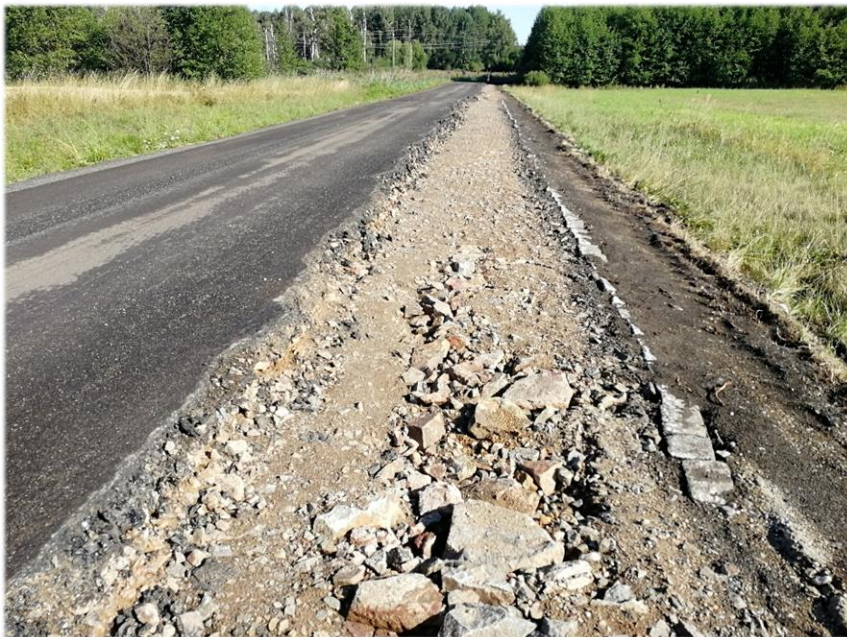
Rozhraní historické vozovky na sil. I. třídy v intravilánu s krajníky v pravé jízdní stopě těžkých vozidel
